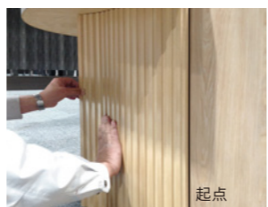
⑦ パネルの貼付け
