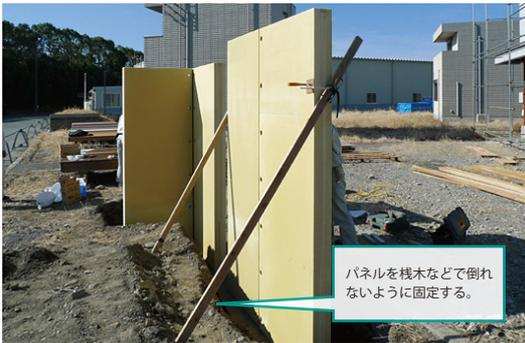
パネルを栈木などで倒れないように固定する。
