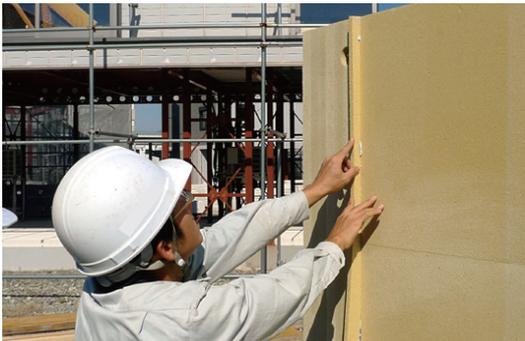
パネル間に接着剤を打設後、パネルと同素材の連結部パッキンを設置する。
