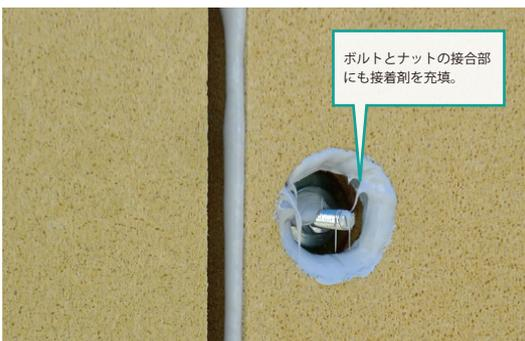
パネル間を接合しているボルト周囲にも接着剤を充填する。接着剤がボルトの緩み止めにもなる。
