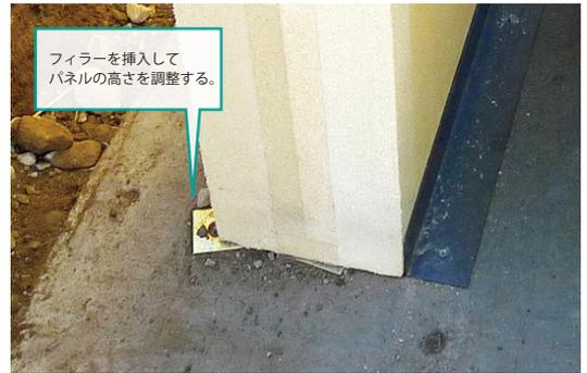
フィラーを挿入してパネルの高さを調整する。
