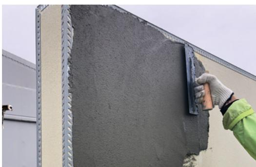
角部には必ず左官用埋め込み定木（コーナー材）を設置する。まずは、厚み2mm程度下地モルタルを塗布する。下地モルタルは根巻コンクリート天端まで施工すること。
