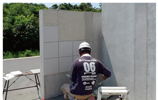
タイルは基材直又は下地モルタル上に弾性接着剤で施工する。
