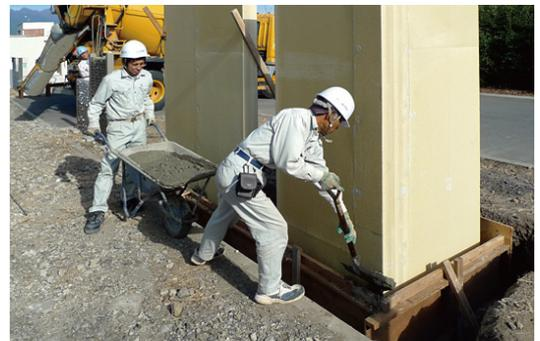
型枠を組み、根巻コンクリートを打設する。寝巻きの両側にバランスよくコンクリートを流し込み、打設後5日間は養生期間として型枠を存置させる。
