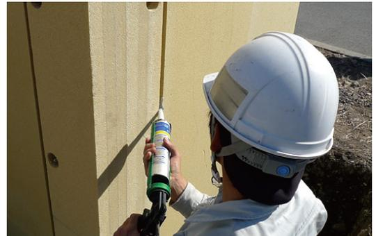
パネル間に接着剤を充填する。コーキングガンで片面ずつ打設する。
