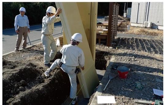
パネルを建込む。下端を墨出し線と脚部定規に合わせる。
