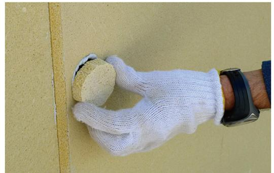
接着剤充填後、パネル間と同様に同素材でパッキングしパネル表面と段差がないようにする。
