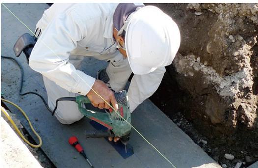
パネル位置を墨出し後、脚部定規を設置する。
