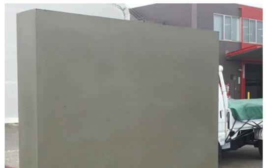
表面を仕上げ下地モルタルの施工を完了する。不燃材（モルタルやタイル等）で覆うこと。乾燥・養生後塗装仕上げをする。（弾性系塗料を使用）
