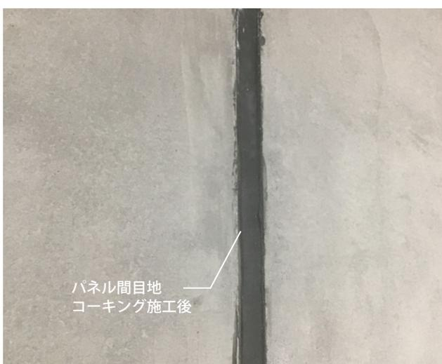
パネル間目地底部のモルタルが硬化したことを確認した後、その目地部にコーキング材を充填して施工完了。
